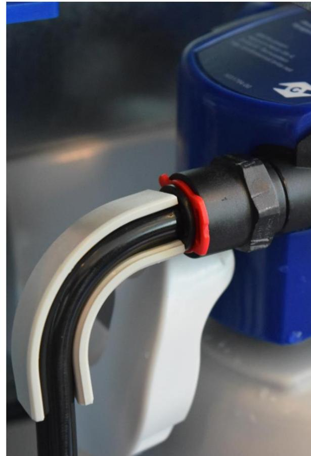
Cierre el asa de bloqueo del cabezal del filtro.
